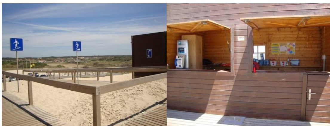
Legenda: Praia do Areão - Passadiço na zona dunar e infra-estrutura na entrada da praia com telefone acessível ao público
