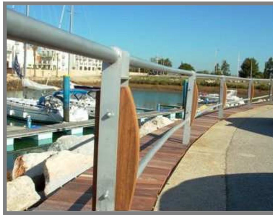
Madeira dos cais re-proveitada para a melhoria da caleira técnica em volta da Marina
