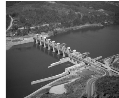
Barragem de Crestuma
